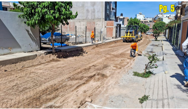
AREQUIPA Infraestructura vial moderna para urbanizaciones en Cayma
